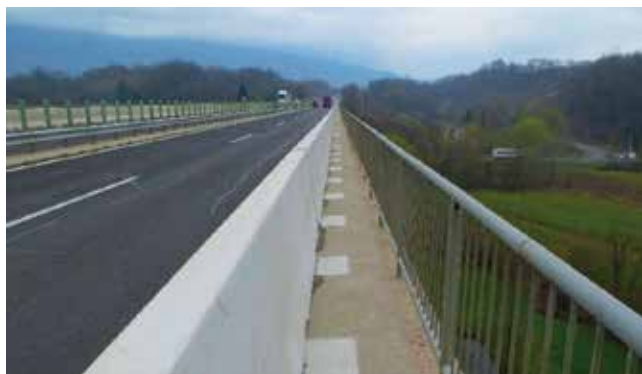
Slika 37: Betonska varnostna ograja
