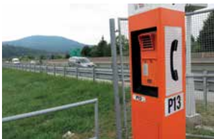
Slika 47: SOS-stebrički na avtocesti
